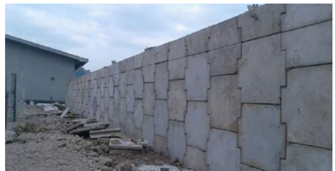
Proyek MSE Wall (Semarang, Jawa Tengah)
