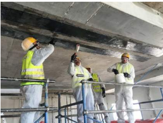
Instalasi CFRP
