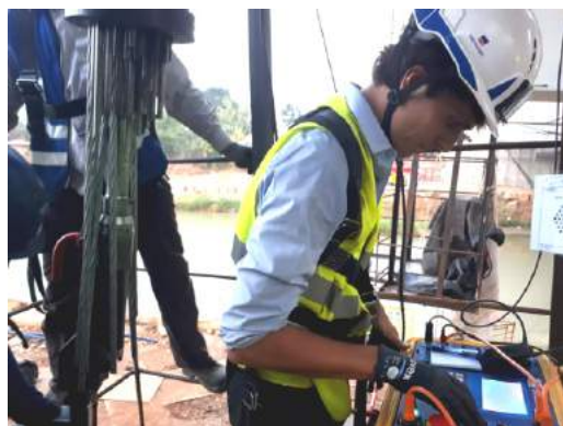
Proses stressing pada Cable Stay (Jembatan Kalikuto)
