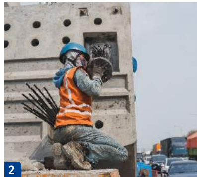
Post Tensioning pada jembatan tipe Box Girder
