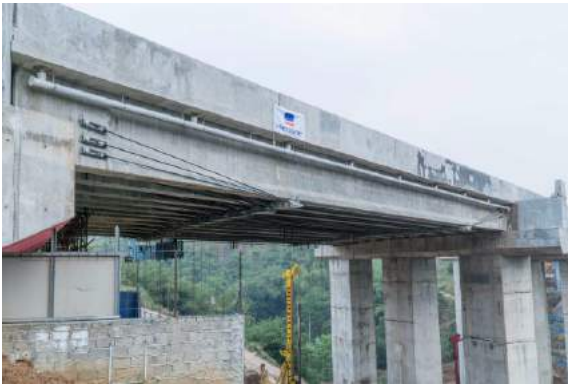
Pekerjaan Eksternal Prestress
