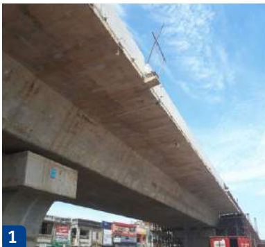
Post Tensioning pada jembatan tipe Box Girder
